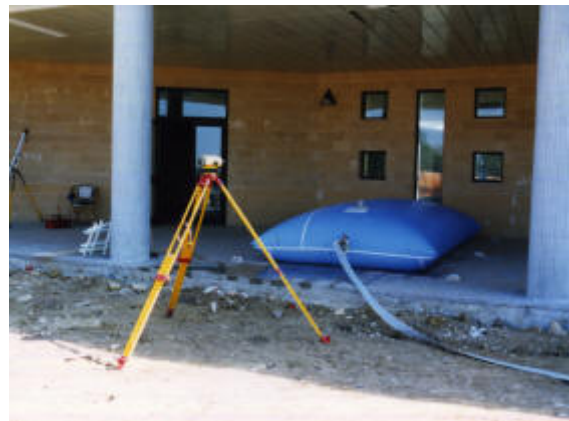
Prova di carico su solaio mediante livellazione
