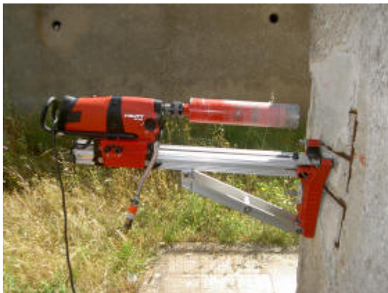
Prelievo da strutture di campioni di calcestruzzo indurito
